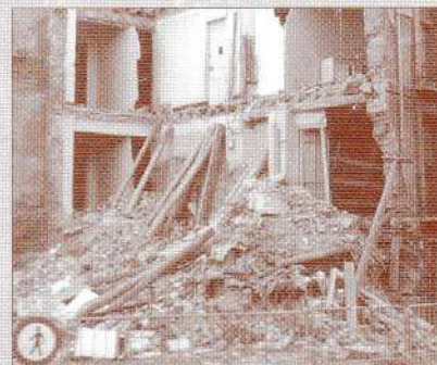
Atentado de ETA en Zaragoza. Hundimiento de la casa donde guardaba los enseres la Cofradía.
